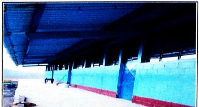
Foto 2: Vista panorámica de las paredes pintadas ya finalizado.
