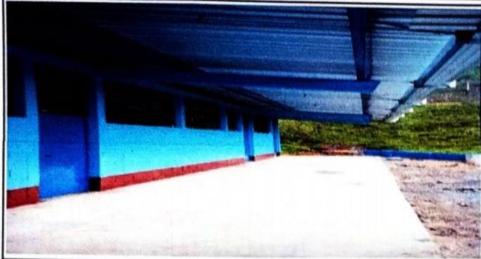
Foto 1: Vista panorámica de la finalización de la torta de concreto del edificio escolar.
