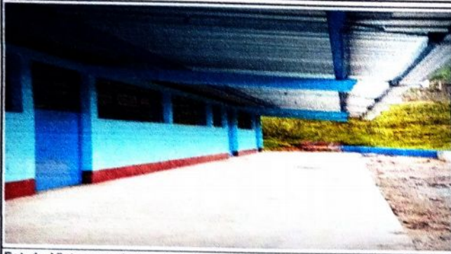
Foto 1: Vista panorámica de la finalización de la torta de concreto del edificio escolar.
