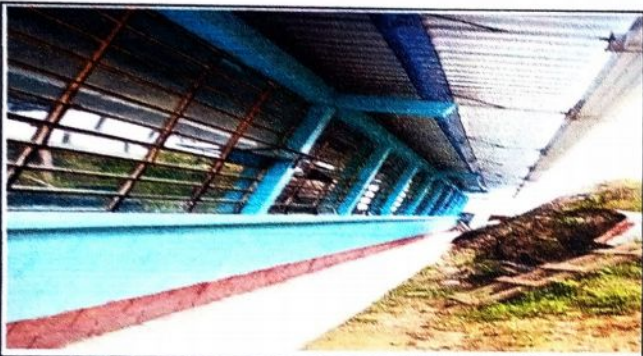
Foto 3: Vista panorámica de canales instalados y bajadas de agua pluvial.
